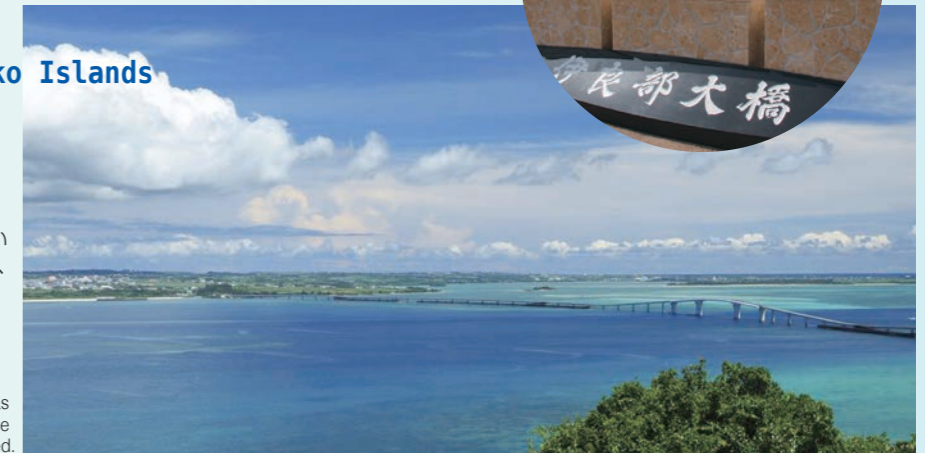
伊良部大橋 Irapu Bridge
