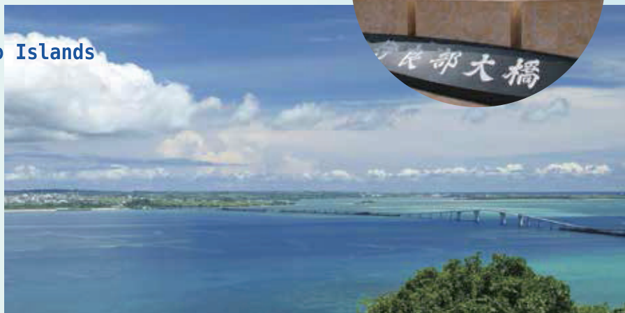
伊良部大橋 Irabu Bridge
